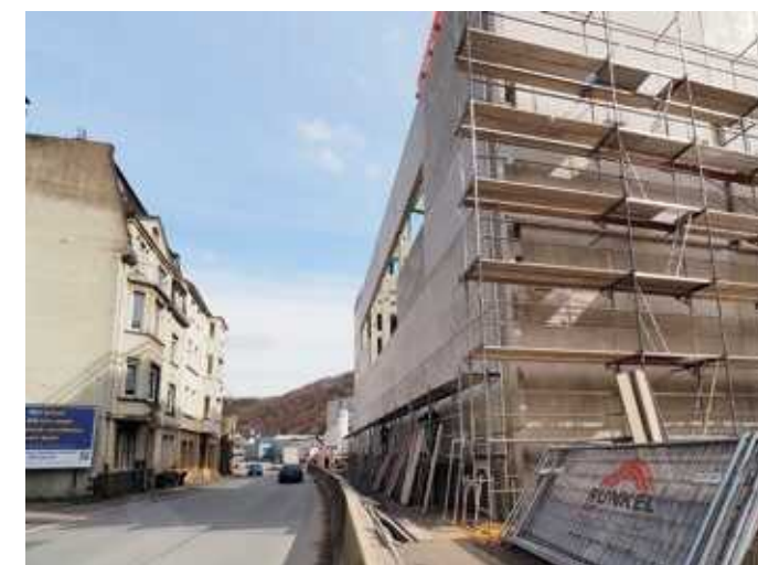
Die neue Halle rechts im Bild wird noch um eine weitere Halle gleicher Höhe in Richtung Bildvordergrund erweitert. Die Wohnhäuser im linken Bildteil werden abgerissen, dort entstehen Parkflächen. /The new hall on the right of the picture will be extended by another hall of the same height towards the foreground. The residential buildings on the left of the picture will be demolished to create car parks.
