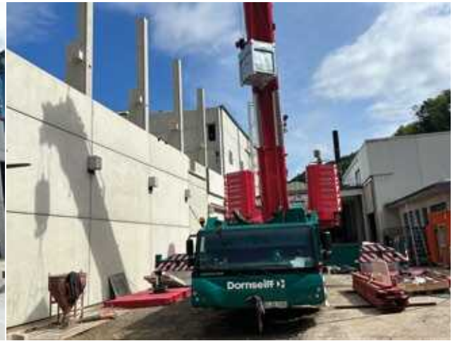
Die Rückseite der Halle. The rear of the hall.
