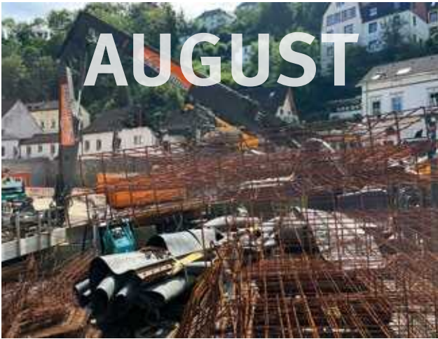
Im August sah die Baustelle noch sehr nach Abbruch aus. In August, the construction site still looked very much like a demolition site.
