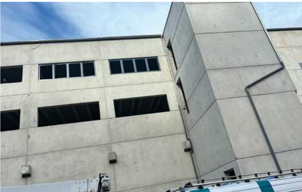
Blick auf die Büroetagen. View of the office floors.
