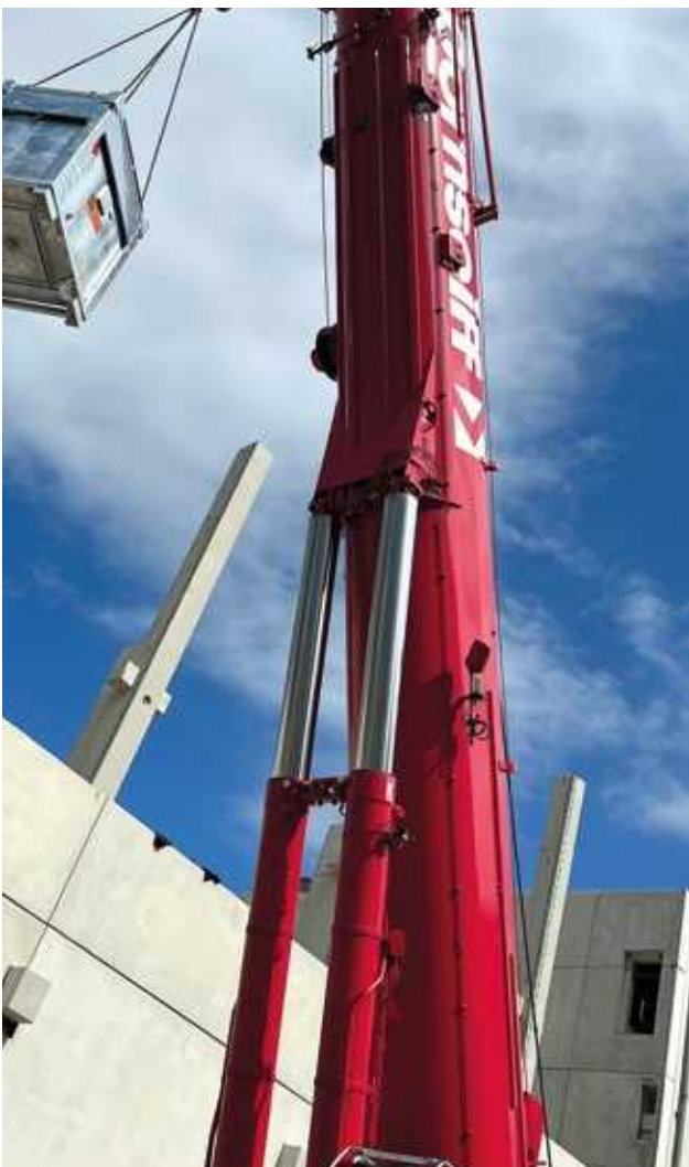
Bei den Bauhöhen ist der Kran das wichtigste Werkzeug. The crane is the most important tool for the construction heights
